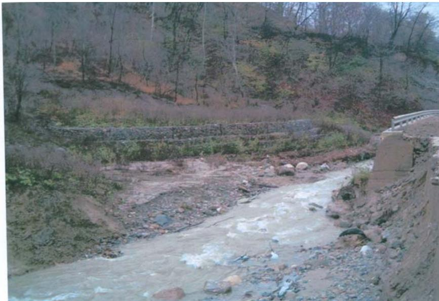
Fig. 3. Travaux de protection des rives, insuffisamment fondés et sous-lavés par suite des crues.
