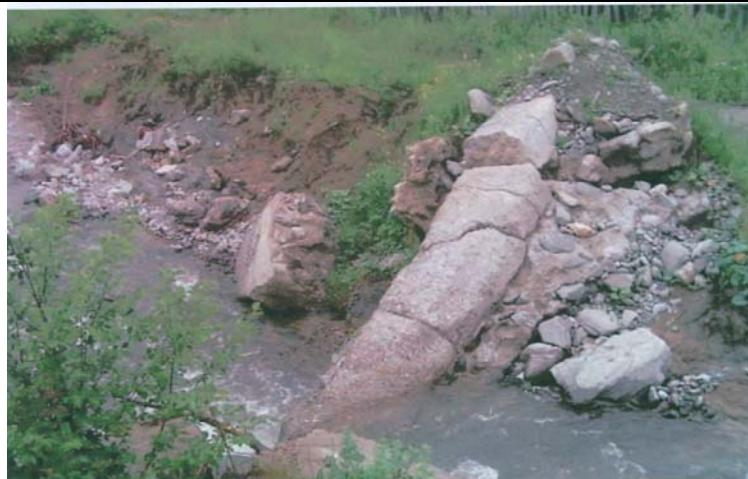
Fig. 4. - Dégradation des travaux de régularisation par suite des crues de l'année 2004.
