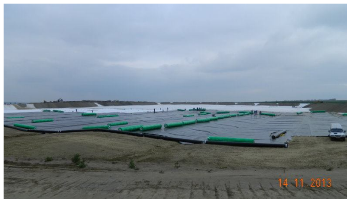
Fig. 5 – Mounting the geomembrane.
