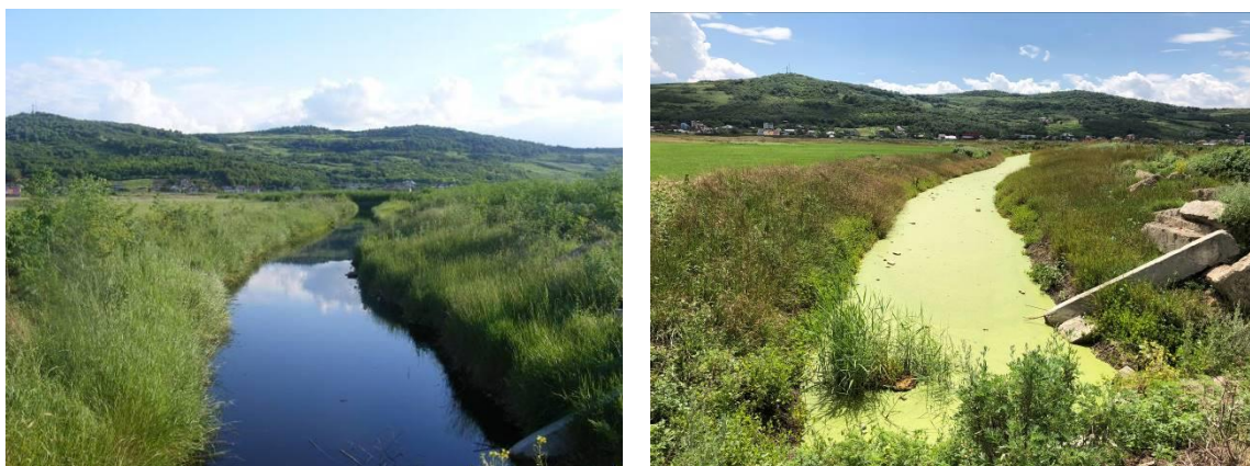
Fig. 4.5. Canalul colector de drenaj (în stânga anul 2015), în dreapta se observă scăderea nivelului apei (anul 2019)
